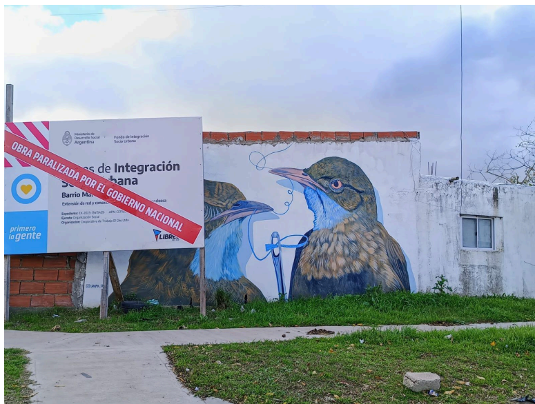
Barrio Libertad obra detenida por falta de financiamiento.
