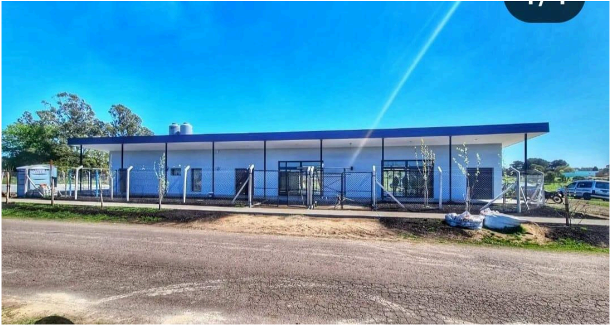
Barrio Santa Rosa del Mar, obra espacio comunitario.
